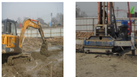
(a) 挖机原位拌合固化剂 (b) 浅层浆体固化 3 d 后施工机械入场
